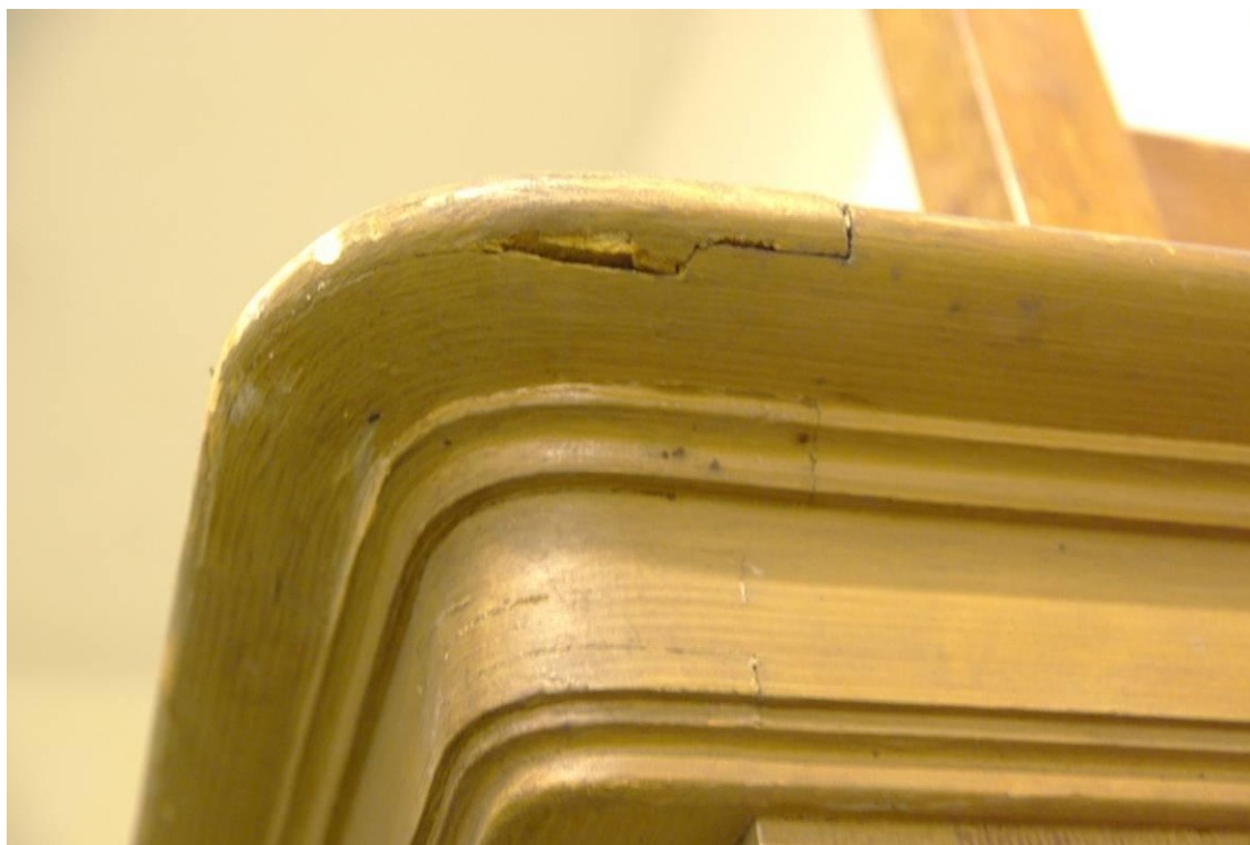
3. kép: Mechanikus sérülés (hiány) a profillécen
