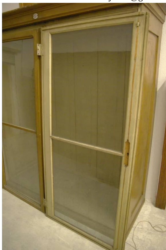
5. kép: Az ajtók belső oldala, hiányzó rúdzár
